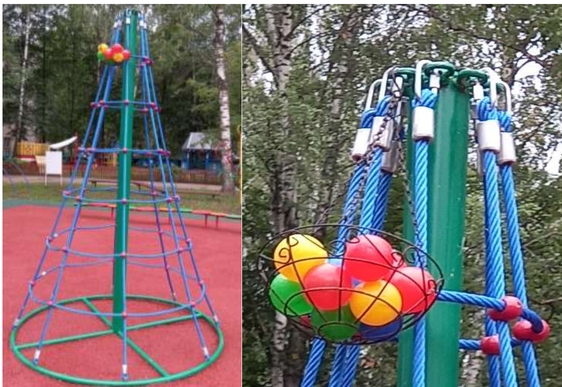
Рис. 24. Общий вид крепления корзины с мячами для метаний на канатном комплексе «Конус»
